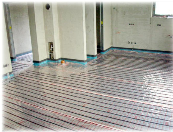
Výstavba bytů Modřanský Háj Praha
